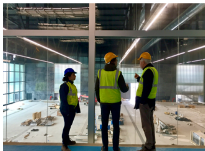
5. OMA. Toulouse. Parc des expositions et Centre de convention. MEETT. Hall des conventions. Vue depuis l'étage des salles de réunion. © Jean Attali.
