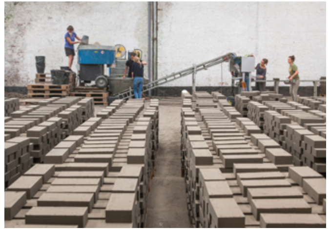
5. Production des blocs de terre crue comprimée par les architectes lors du chantier du centre éducatif, 2018. © Thomas Noceto.
