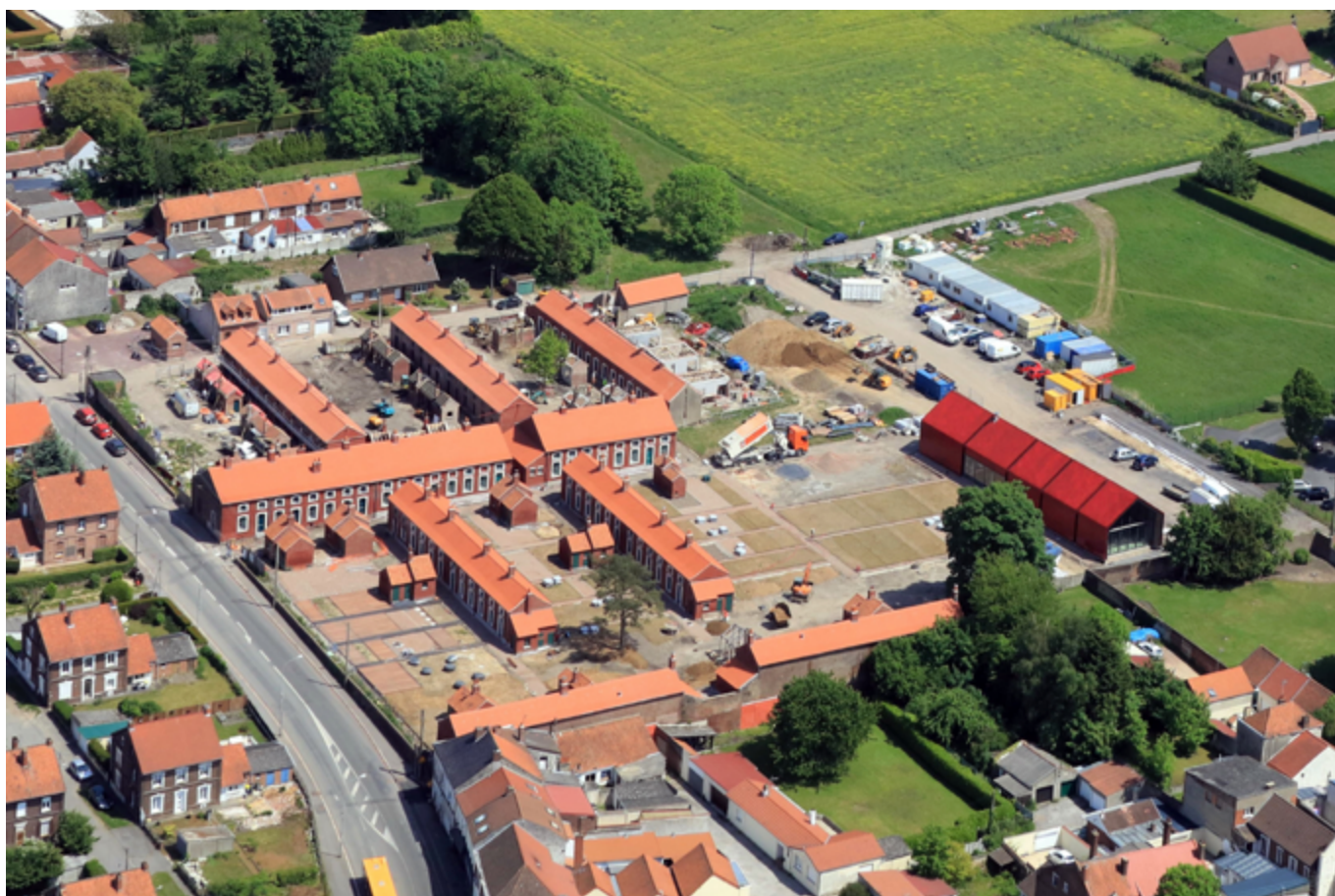
1. Vue aérienne de la cité des électriciens en cours de rénovation. © Philippe Prost / AAPP architectes, photo Philippe Frutier / Altimage, 2017.
