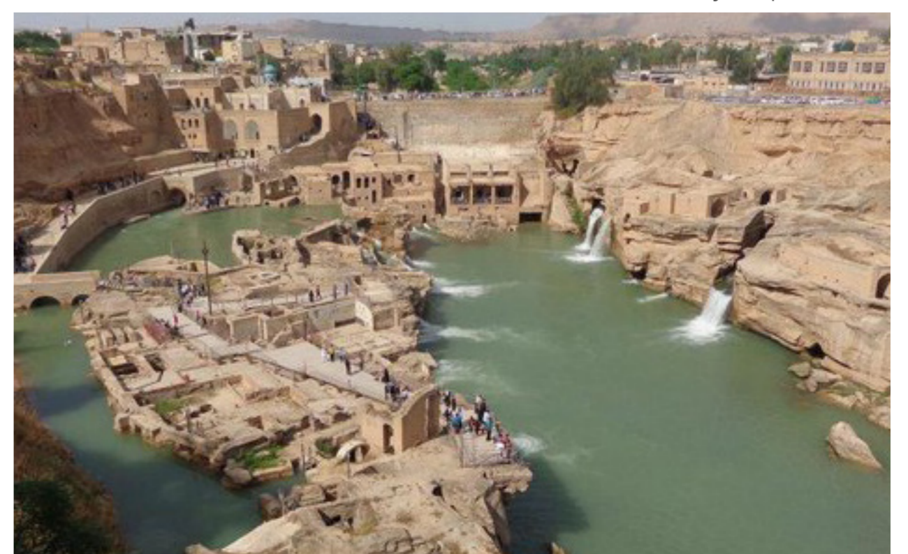
Système hydraulique de Shushtar - Khusestan - Iran
