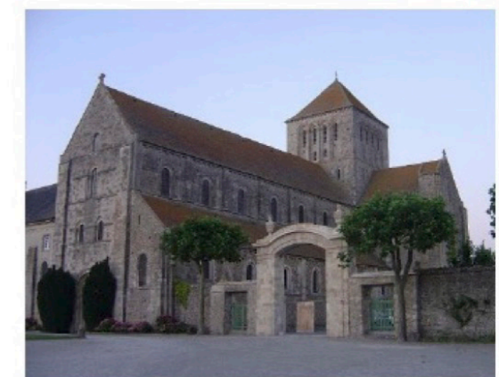
Figure : la façade occidentale de l'abbatiale est dégagée et percée, permettant ainsi aux visiteurs d'accéder aux jardins par l'abbatiale photographie (2010 environ), lessay.fr, < http://www.lessay.fr/abbatiale-lessay/manche.htm > [site visité le le 03.06.20]
