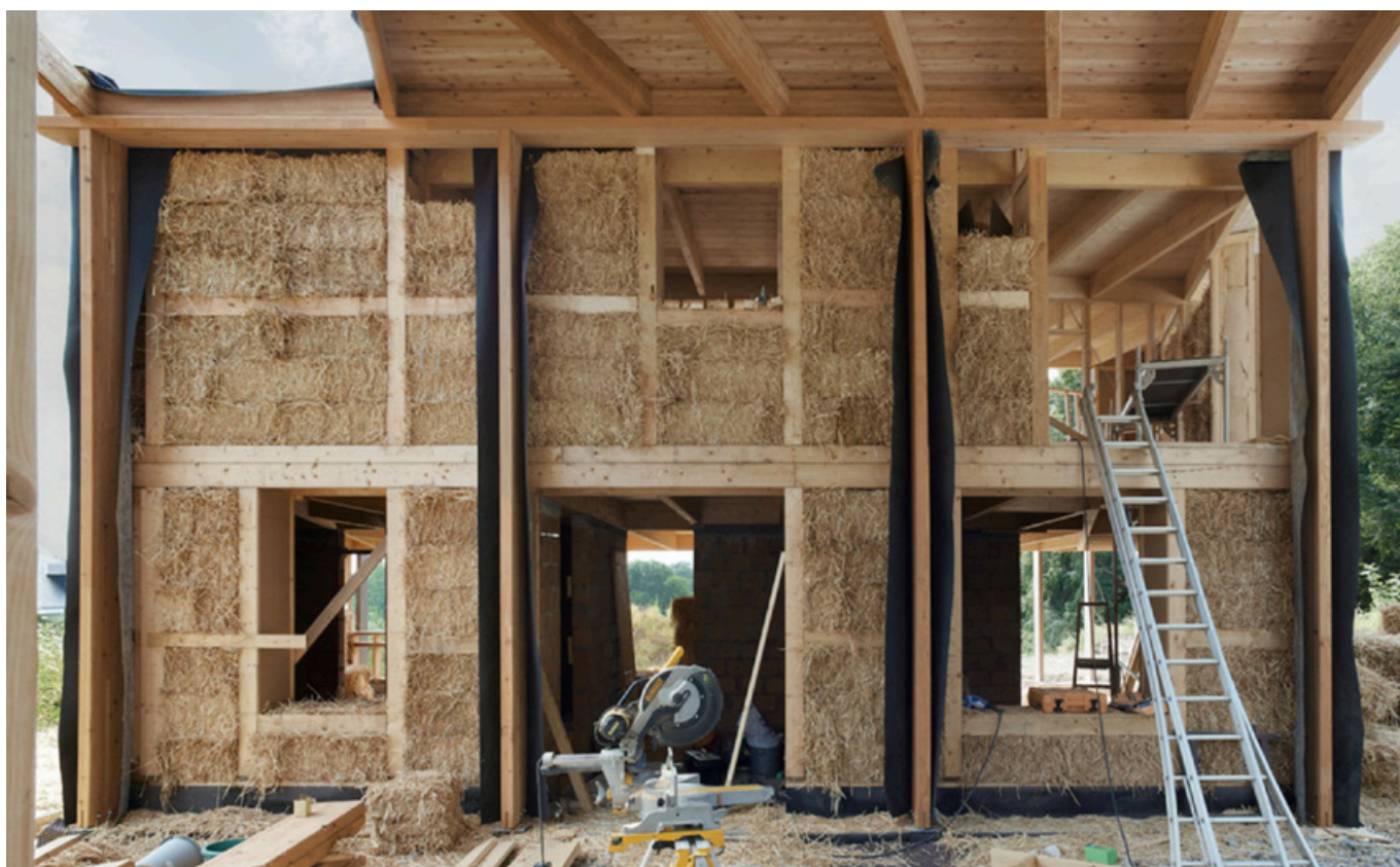
1. Mise en œuvre du système constructif bois et paille par l'artisan au cours du chantier d'un projet conçu par le bureau d'architectes, 2019. © Giulia Frigerio.
