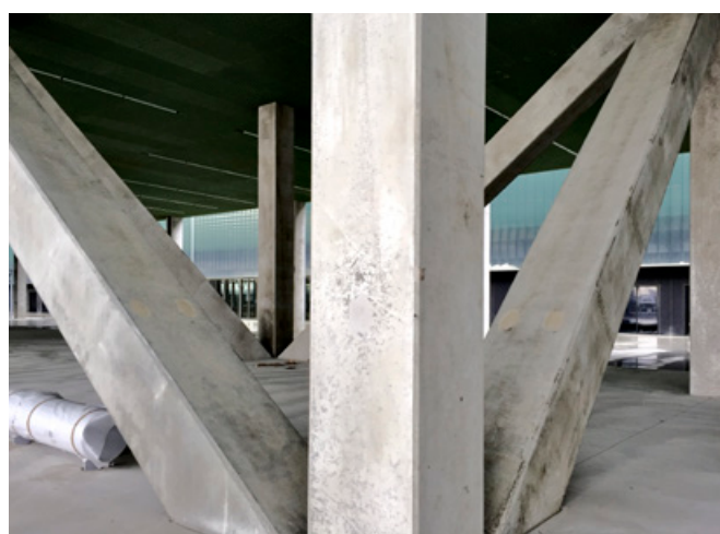
2. OMA. Toulouse. Parc des expositions et Centre de convention. MEETT. Détail de la structure porteuse. © Jean Attali.
