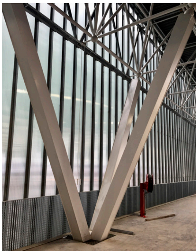
4. OMA. Toulouse. Parc des expositions et Centre de convention. MEETT. Hall des expositions. Détail de la structure. © Jean Attali.
