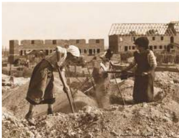
Auto-construction d'un lotissement coopératif à Vienne selon les plans d'Adolf Loos, 1924
